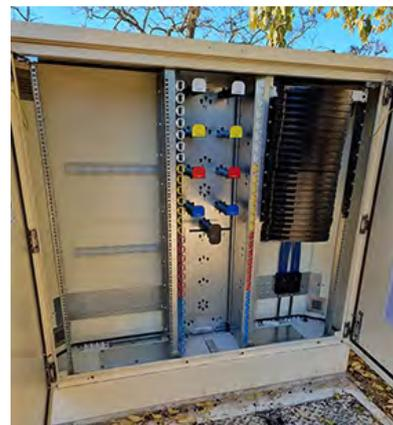
Les travaux pour l'installation de la fibre progresse, l'armoire de distribution a été installée, et le déploiement des cables fibres sur l'ensemble du village et des hameaux est terminé. Il reste à effectuer la liaison entre le NRO (noeud de raccordement optique) entre Castelnau Valence et l'armoire de Baron. Nous devrions pouvoir disposer de la fibre au courant de l'année 2022.
